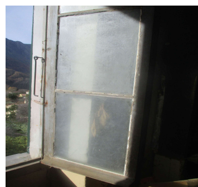
Ech 15 : Mastic fenêtre sans amiante
