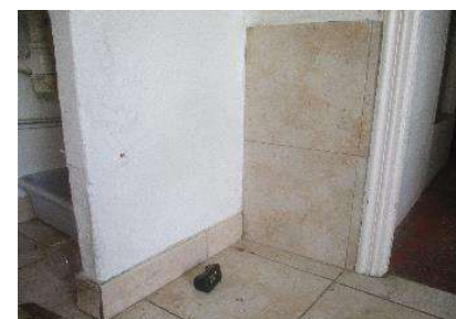
Photo 2 : carrelage et plinthes rose sans amiante car posés après 2010 dans entrée et cuisine
