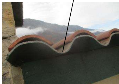
Ech 10 : Plaques Sous Tuiles en fibro-ciment sans amiante
