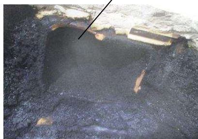
Photo 5 : conduit de fumée en terre cuite sans amiante dans cheminée de la cuisine
