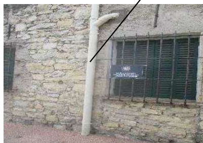
Photo 1 : conduit d'EU en fonte sans amiante sur façade (côté rue)
