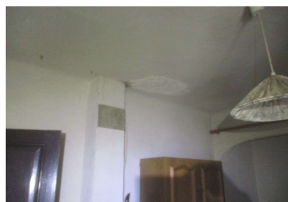
Ech 12 : Enduit mural et plafond crépi sans amiante
